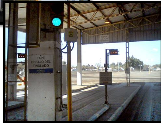
Control de Acceso.
