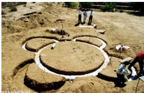
Cimientos de una estructura SuperAdobe (fotografía cortesía de Cal-Earth)
