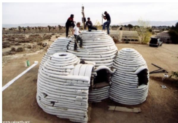
Una estructura SuperAdobe característica (fotografía cortesía de Cal-Earth)
