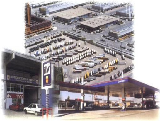
Centro de Servicios al Vehículo - Truck Center
