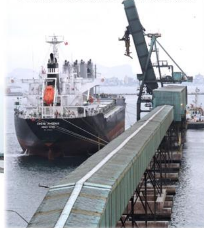
Puente de acceso al muelle
