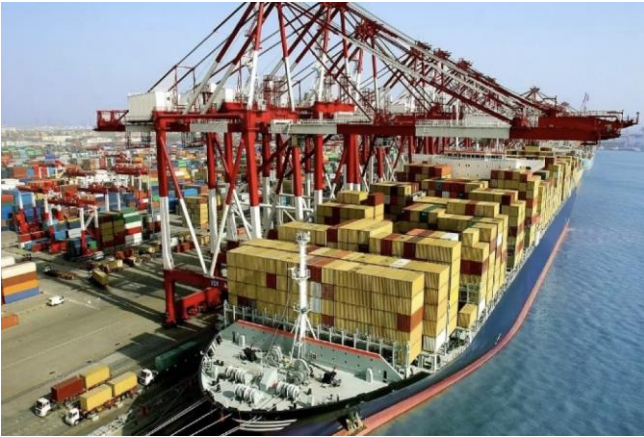
Modernización de muelles
