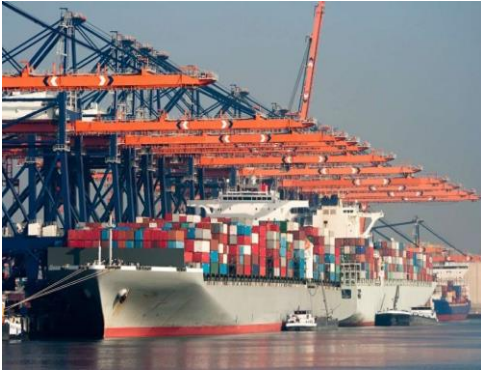
Modernización de muelles
